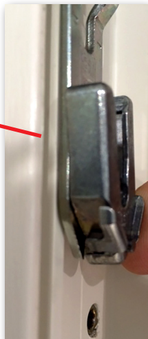
Detail draai- mechanisme
